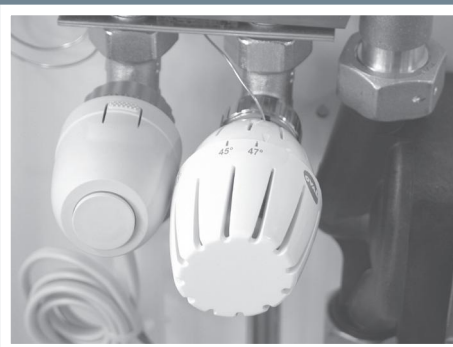
Telestaten tilsluttes styreenheden.
