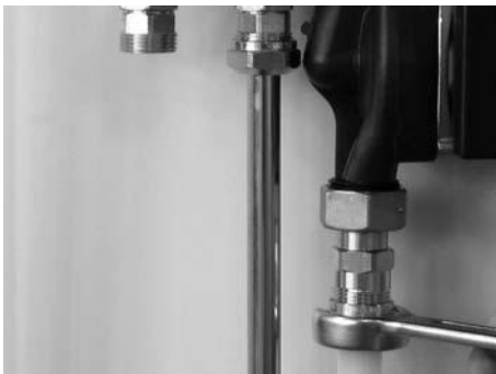
Tilslut frem gulvvarme.
