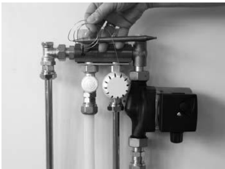
Følelement for termostatventil.
