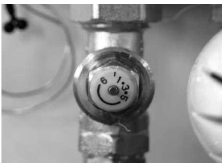
Indregulering foretages på forindstillingsskruen.
