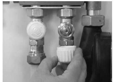
Gulvslangen vandfyldes fra anlægget ved at åbne termostatventilen.
