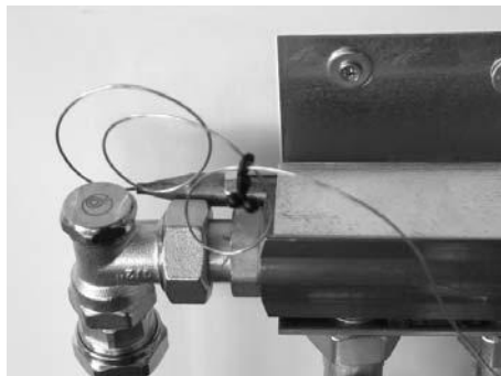
Føleren anbringes mellem blanderør og ophængsbeslag.
