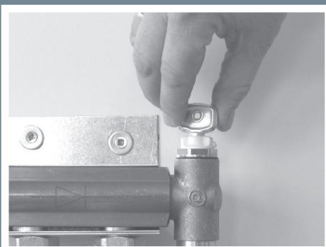
Udluftning af anlægget foretages på udluftningsskruen
