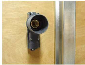
Gipsdåse Monteret på bagvæg.
