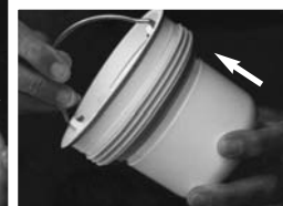
Når der ikke kommer mere vand lukkes og tættes vandlåsen
