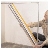
1. ISOVER BoaFlex placeres på røret. Afhængigt af pladsforhold deles ISOVER BoaFlex på længden.
