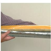
1. ISOVER BoaFlex lægges omkring røret. Afhængigt af pladsforhold, deles ISOVER BoaFlex på længden.
